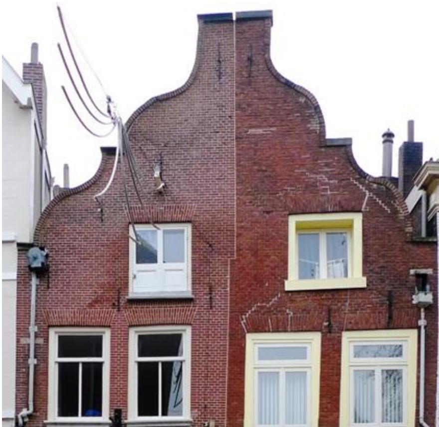
Opgedeeld huis. Links onoordeelkundig gereinigd en gevoegd, het metselwerk rechts is ongewijzigd.
