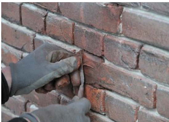
Reparatie van baksteen voorafgaand aan het voegwerk met reparatiemortel die is bereid met de juiste kleur en korrelstructuur.
